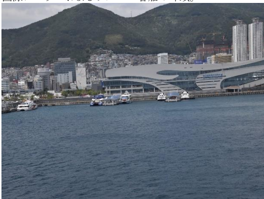
国際客船ターミナルビルと、停泊する日韓航路の高速船。
